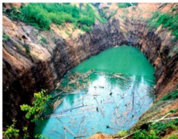
Figura 2.4 – Área Colapsada por exploração de potássio na mina de Berzikovskiy-Rússia.
